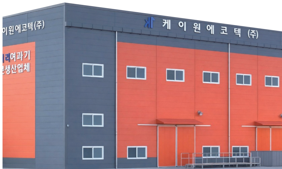
한강 독성공원에 설치된 케이원테크의 여과기.
